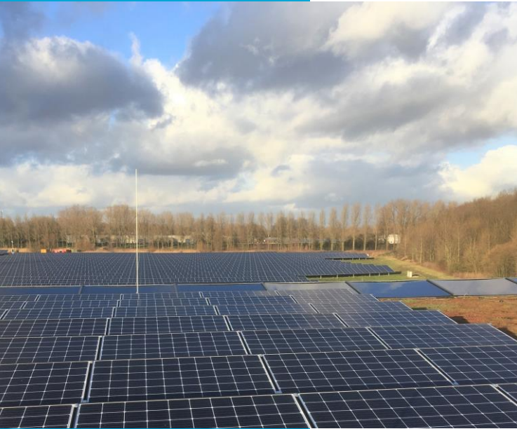
Zonnepark op WRK terrein + op dak KWR gebouw
